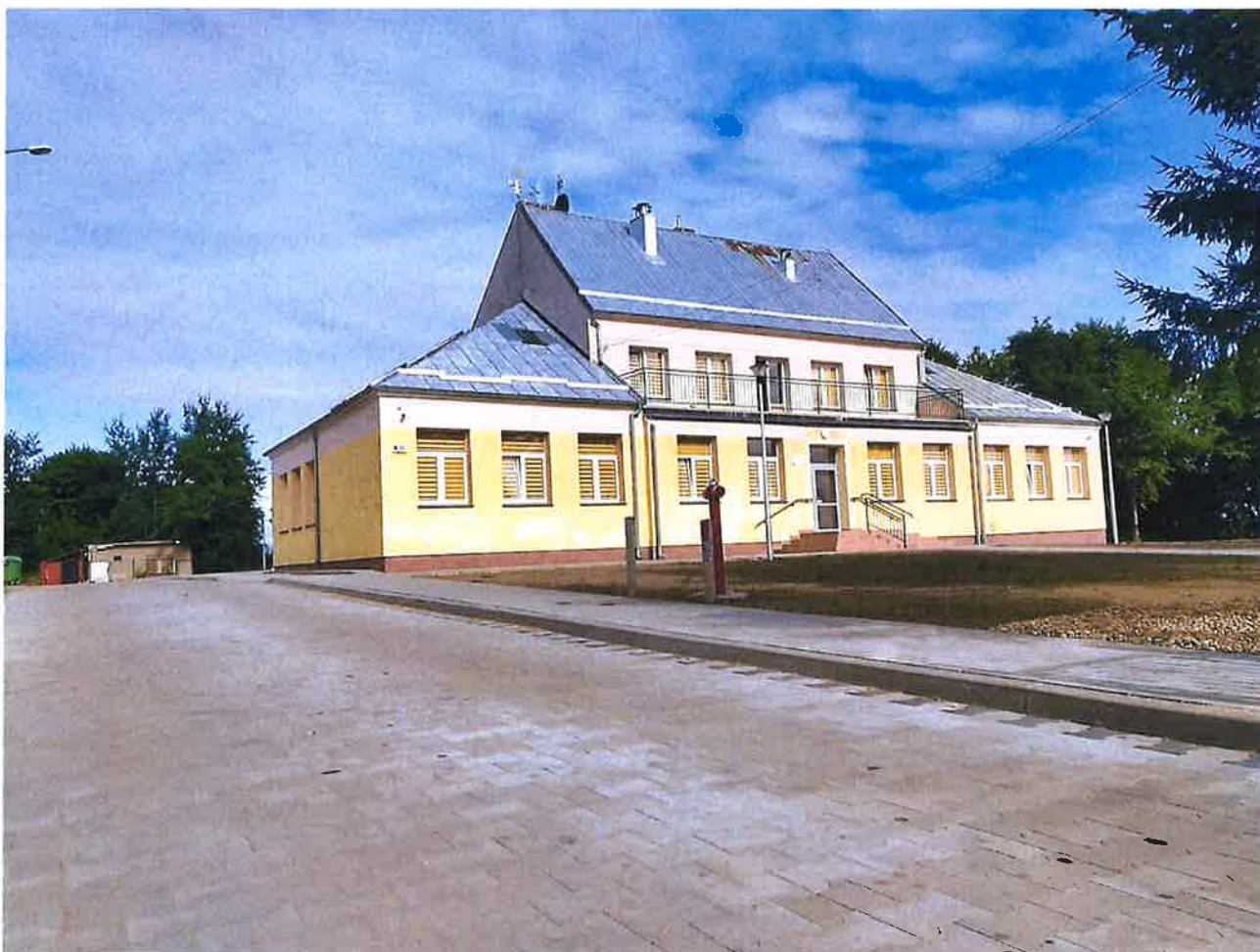
Zdjęcie 10. Budynek Domu Pomocy Społecznej w Mścichach.
