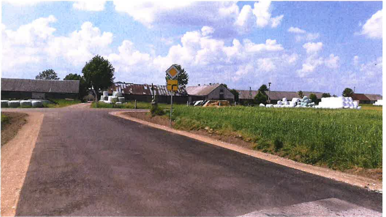
Zdjęcie. 1 Droga w msc. Karwowo po przebudowie.
