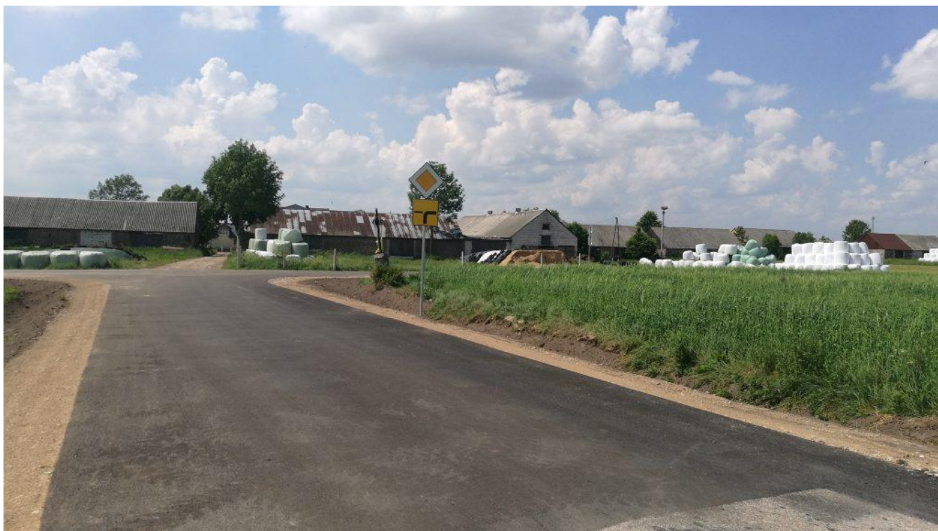
Zdjęcie. 1 Droga w msc. Karwowo po przebudowie.
