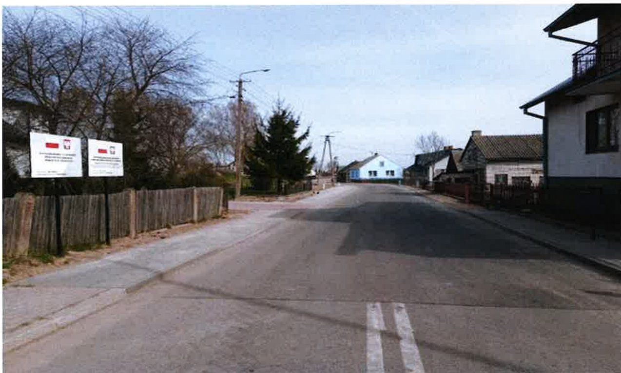
Zdjęcie 1. Droga gminna nr 104158B, nr 162714B i nr 162717B w msc. Klimaszewnica
