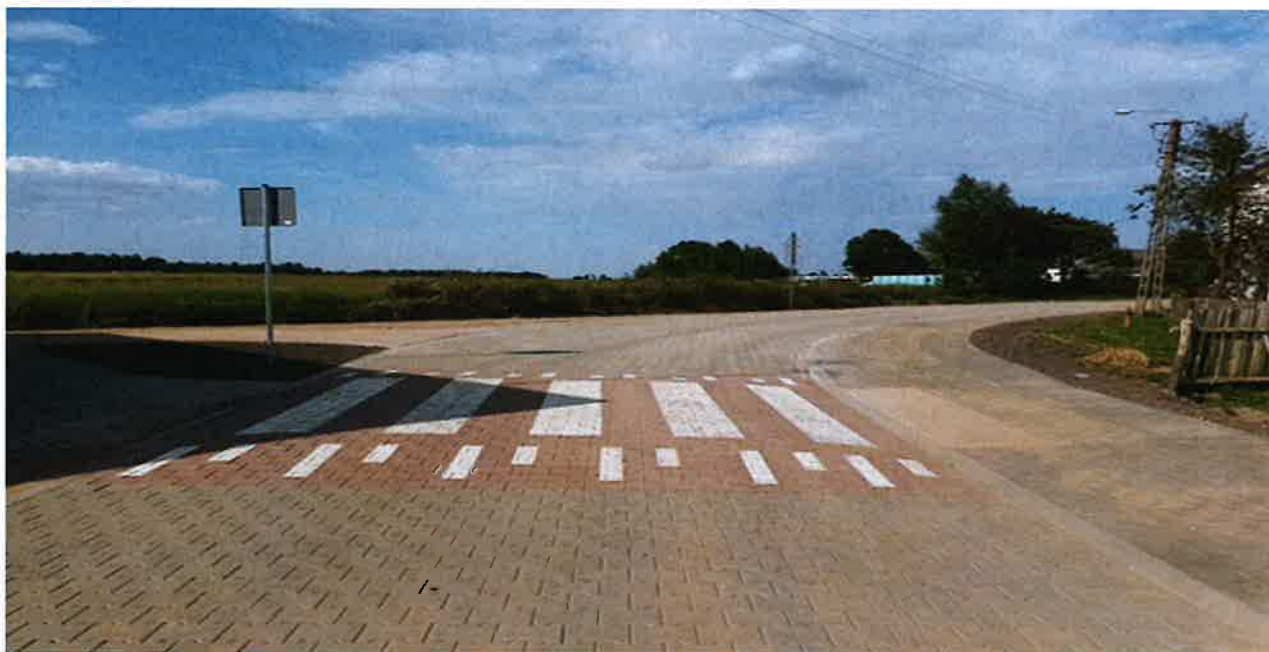
Zdjęcie 2. Przejście dla pieszych w Zakrzewie
