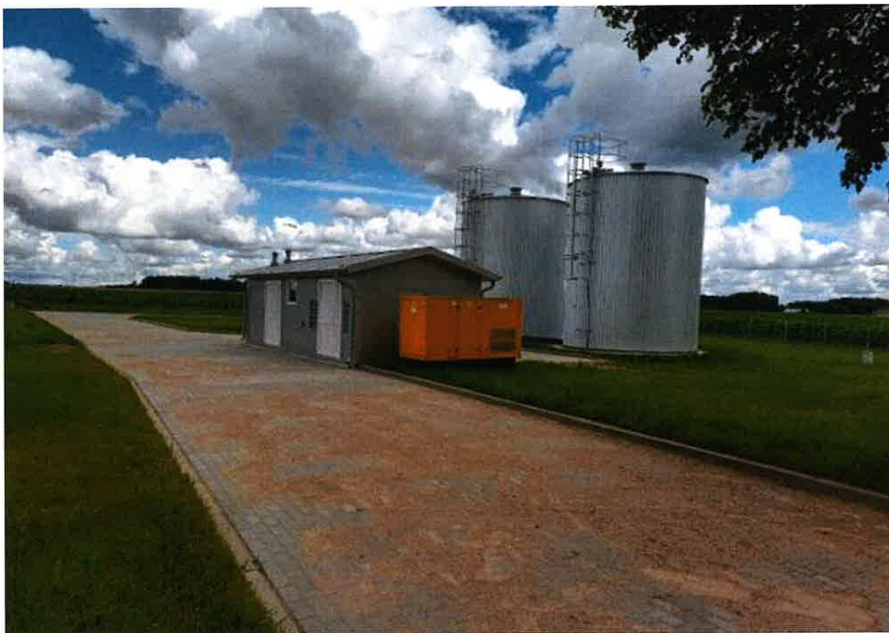
Zdjęcie 11. Przepompownia wody w msc. Święcieninie
