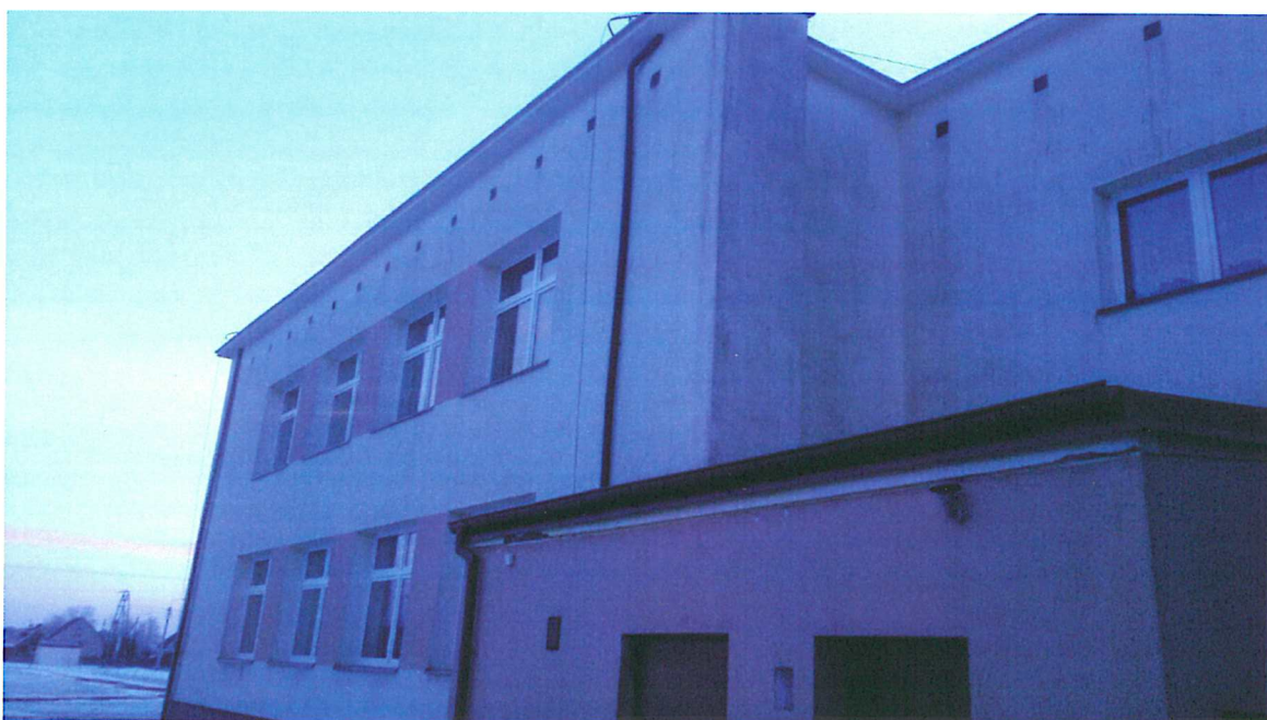
Rysunek 3. Przybudówka do budynku szkoły przeznaczona na pomieszczenie kotłowni (źródło własne)
