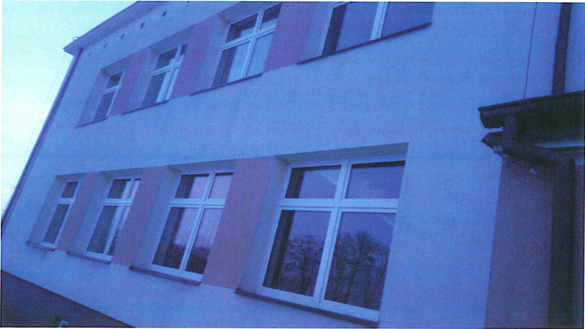
Rysunek 4. Stolarka okienna w budynku szkoły w Słuczu (źródło własne)
