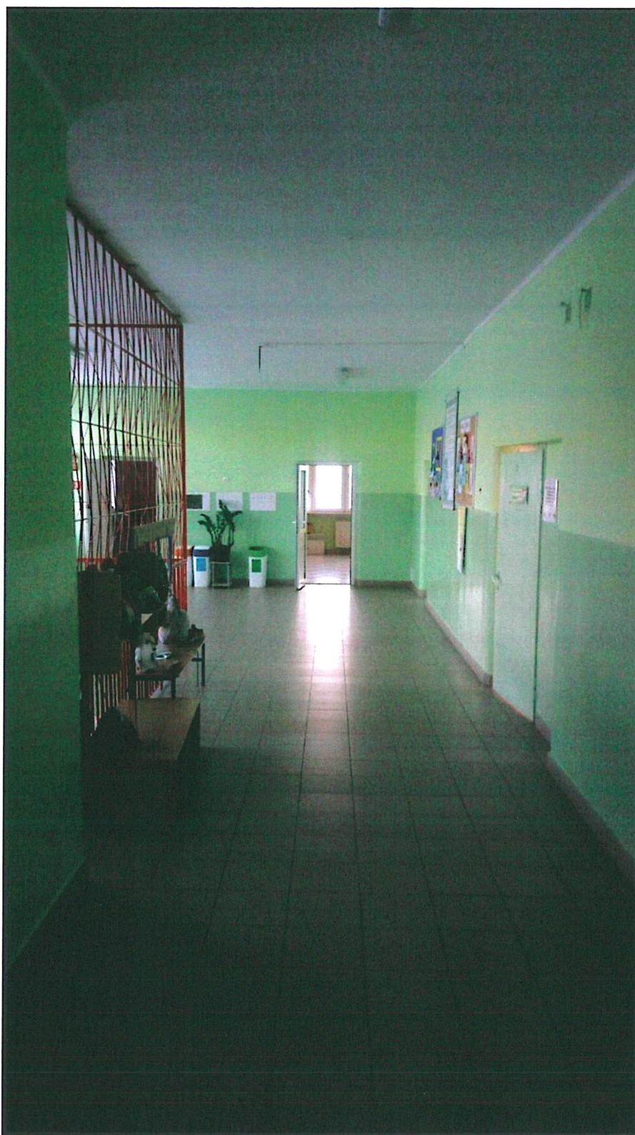
Rysunek 17. Sufit nad korytarzem na pierwszym piętrze w szkole w Słuczu - miejsce prowadzenia nowych instalacji c.o. (źródło własne)
